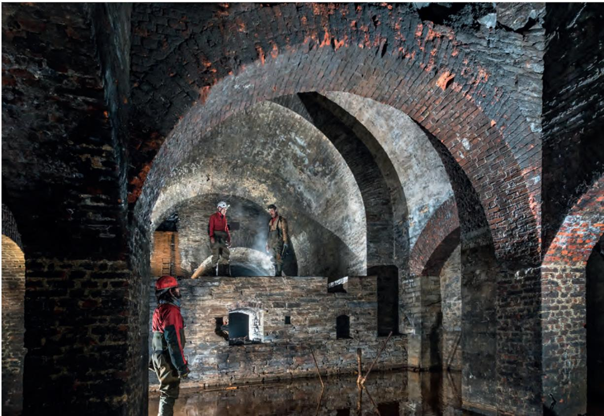
Abb. 17: Blick durch die Schachthalle auf die Dampfmaschinenplattform in der Bildmitte. Im Hintergrund (erleuchtet) ist das Tonnengewölbe der Kesselhalle erkennbar (Foto: Deutsches Bergbau-Museum Bochum/P. Thomas).
