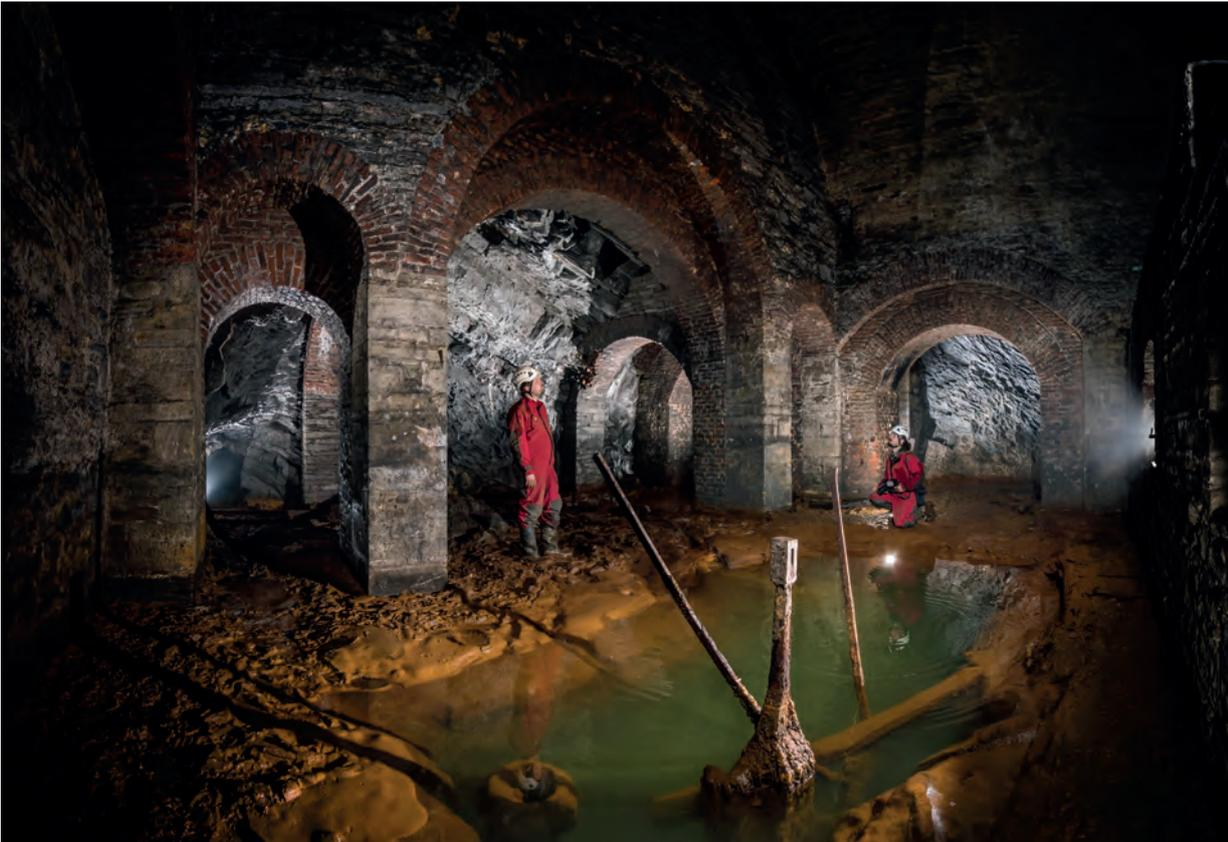
Abb. 18: Blick durch die Schachthalle, Dampfmaschinenpodest am rechten Bildrand und Zugang zur Halle im Hintergrund links (Foto: Deutsches Bergbau-Museum/P. Thomas).
