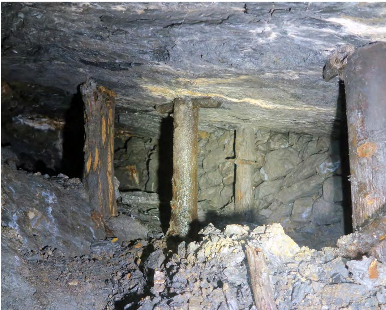
Abb. 11: Ausgeerzte Gangspalte im oberen Bereich des 1. Südlichen Mittels. Schön sind die Holzstempel und die Versatzmuer zu sehen, welche die Firste stabilisieren (Foto: Verein für Siegerländer Bergbau e.V./A. Kosseck).
