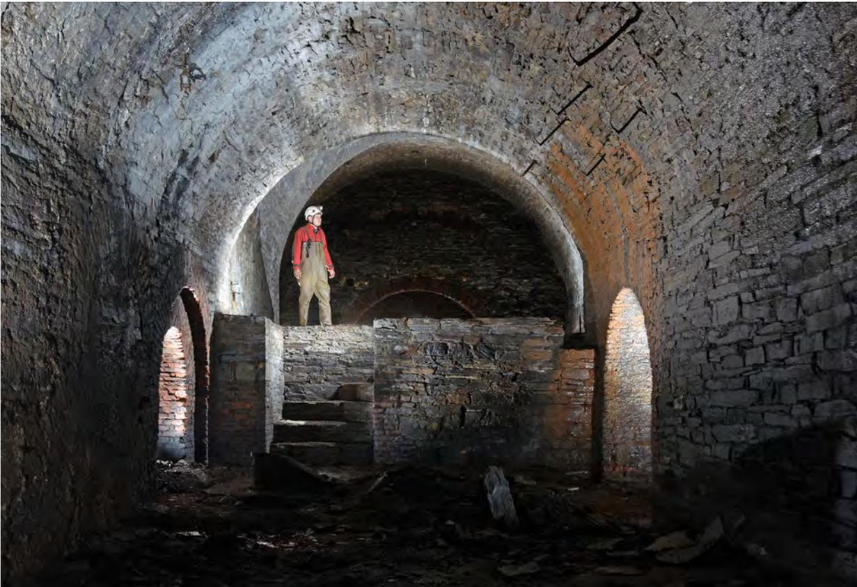
Abb. 15: Blick von der Kesselhalle auf das Dampfmaschinenpodest. Rechts die Verbindung zur parallel vorbeiführenden Strecke, links der Kohlebunker (Foto: Deutsches Bergbau-Museum/P. Thomas).
